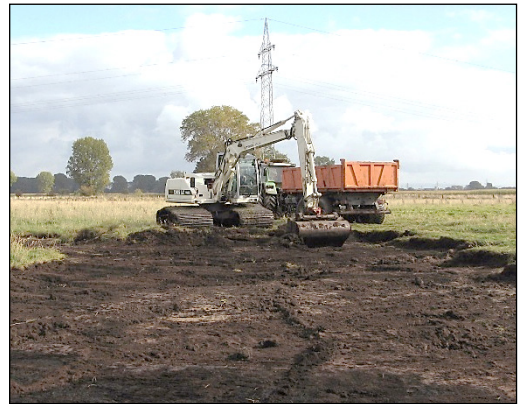
Abb. 24: Flacher Abtrag von Oberboden im Osten des Blockes IV (Foto: D. Esplor, Oktober 2008).
