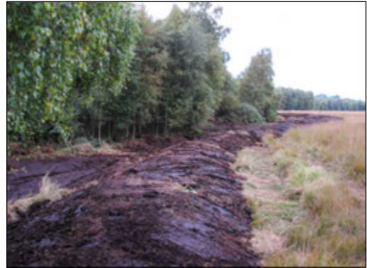
Abb. 2: Neubau von Torfdämmen zur Wiedervernässung (Foto: Dirk Esplör)
