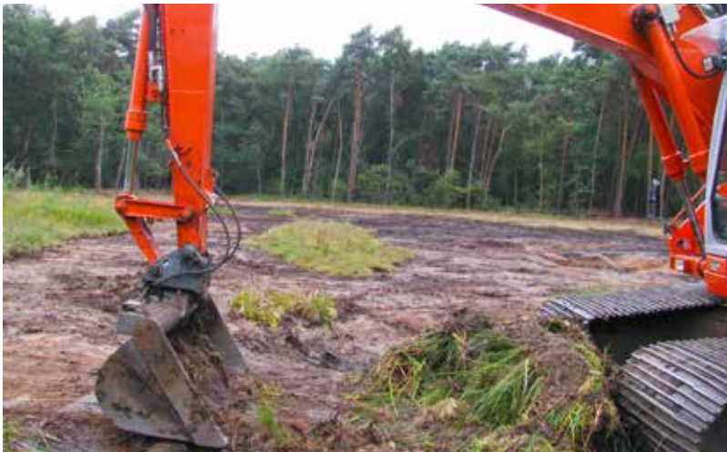
Abb. 4: Flaches „Abschieben“ von Flächen mit einem Bagger. Foto: D. Diesing (2009)
