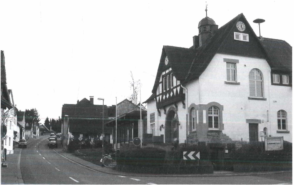
Abb. 2: Die Gegenüberstellung historischer und rezenter Fotos ermöglicht, Veränderungen der Dorfvegetation durch Analogieschlüsse zu erkennen (Dorfschule und Straße in Michelbach, Hochtaunuskreis, Hessen; oben: 1940 Original: Kreisarchiv Bad Homburg; unten: 2005). Während im Jahre 1940 die Standortbedingungen für das Lolio-Polygonetum arenastri (unversiegelte Trittstellen), für das „ Potentilletum anserinae “ und feuchtigkeitsliebende Therophytenfluren (feuchte Trittstellen, unversiegelte Abflussrinnen), das Urtico-Malvetum neglectae (Hühnerausläufe) und Arction-Gesellschaften (unversiegelte Saumbereiche) gegeben waren, erlauben die Bedingungen im Jahr 2005 lediglich die Existenz des Bryo-Saginetum und von Scherrasen ( Cynosurion ).
