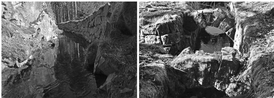
Abb. 2: Der Morgenbrodstaler Graben (links), der Wasser aus der Söse Richtung Clausthal führt, ist an einigen Stellen durch den anstehenden Felsen getrieben worden. Am Ringer Graben (rechts) bei Clausthal sind an einigen Stellen die kleinen Gewölbebrücken zum Winterschutz als spezielle Elemente der Kulturlandschaft noch erhalten geblieben.
