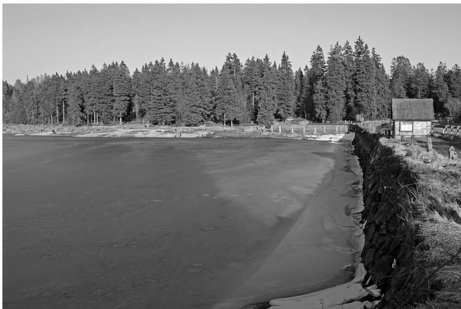
Abb. 5: Der Oderteich diente der Wasserversorgung der Gruben in St. Andreasberg über den Rehberger Graben.
