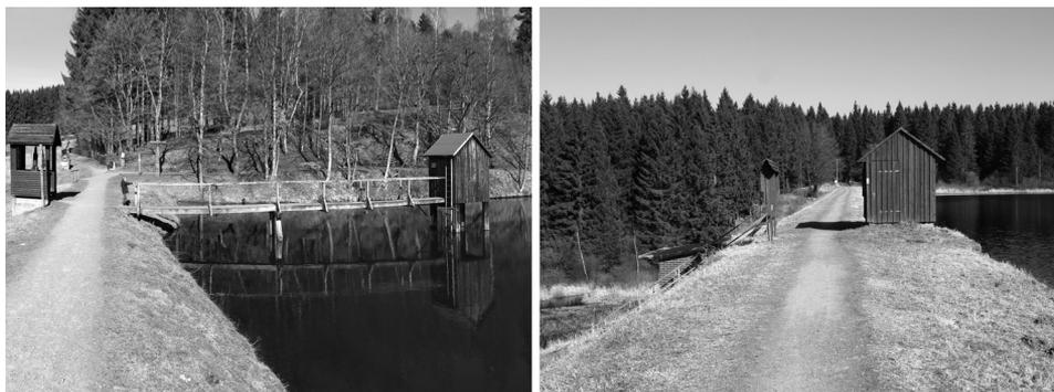
Abb. 4: Gegenüberstellung der alten und neuen Dammkonstruktion. Das Striegelhaus des nach alter Bauart 1763 errichteten Carler Teichs (FESSNER et al. 2002) steht im Wasser (links), während das Striegelhaus des Hirschler Teichs bei einer 1765 erfolgten Dammerhöhung (LIEBMANN 2012) nach neuer Bauart auf der Dammkrone errichtet wurde.
