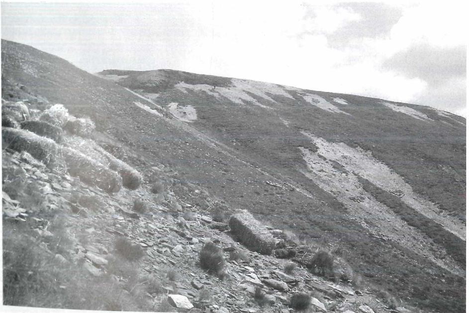
Abb. 1: Anwendung von Bitumen-Strohdecksaat im alpinen Gelände am Pfannhorn (Südtirol, Italien).
