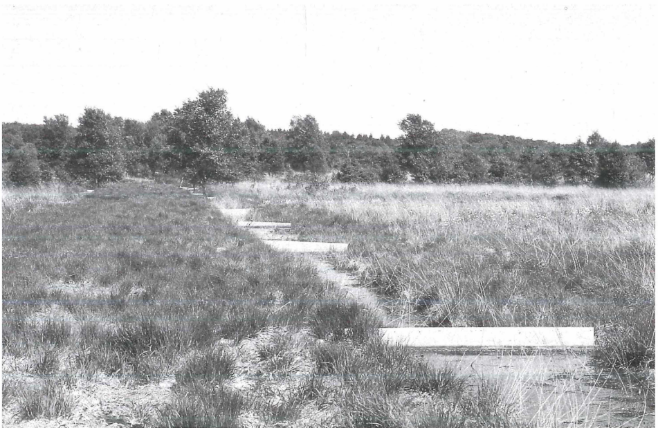
Abb. 4: Gestaffelte Staus aus Planboardplatten im Dosenmoor, Schleswig-Holstein.
