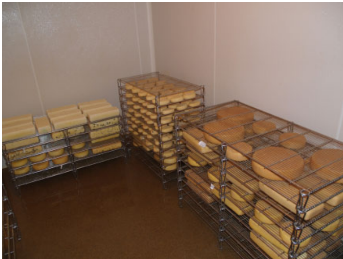
Abb. 2: Baulich entsprechender Reiferaum mit Lagerung von Käse auf Horden
