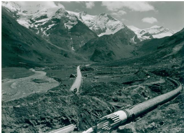
Kaprun: Wasserfallboden mit provisorischem Holzrohr
