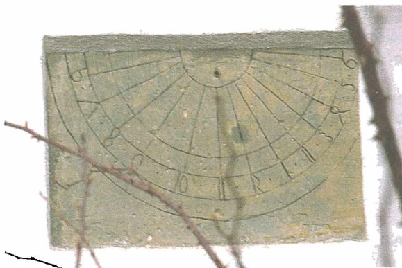
Abb. 52: Waischenfeld, Kapelle St. Laurentius. Süduhr im Übergang vom Mittelalter zur Neuzeit. Der Schattenstab fehlt.
