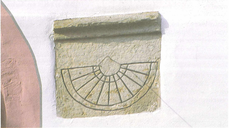
Abb. 3: Thurnau-Trumsdorf, Ev. Pfarrkirche: zehnteilige spätmittelalterliche Sonnenuhr. Der Schattenstab ist falsch eingesetzt und aus der Waagerechten "polwärts" nach unten verbogen worden. Das zeigt der nicht zum Zifferblatt passende Schatten.
