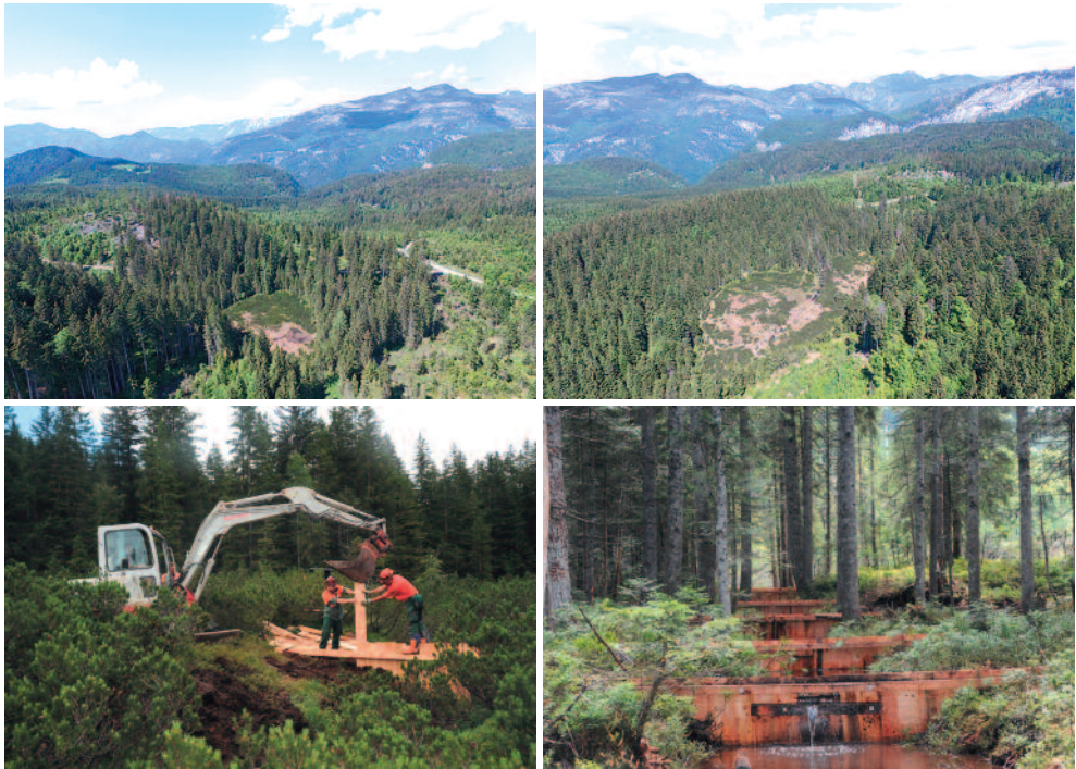
Abb. 1: Rossstallmoos (oben links) und Langmoos (oben rechts) aus der Vogelperspektive; Einbau der Spundwände im Latschenfilz (unten links) und Spundwandkaskade im Moorrandwald des Langmooses (unten rechts). Fotos: G. Fischer
