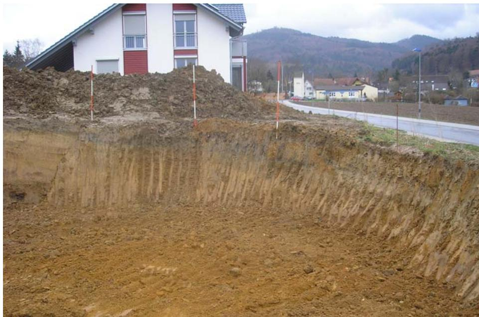
**Abb. 5:** Baugrube nördlich der General- von- Holzling- Straße, Bollschweil: Auehlm über Lösslehmlagen. Im Untergrund Ältere Schotter (Breisgauschichten).
