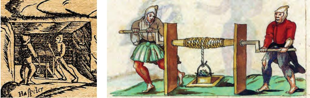
**Abb. 11:** Die Verwendung des Haspel auf zeitgenössischen Darstellungen. Linkes Bild: Haspel aus der „Comographia“ von Sebastian Münster (1545/50). Rechtes Bild: Haspel im „Schwazer Bergbuch“ von Anonymus (1556). – **Fig. 11:** The use of the reel in contemporary description. Left picture: reel in “Comographia” by Sebastian Münster (1545/50). Right picture: reel in “Schwaz Mining book” by Anonymus (1556).
