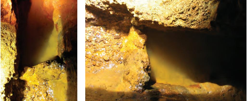
**Abb. 26:** Links: Steinere Staumauer im spätmittelalterlichen Abbaubereich (Ansicht von vorne/oben). Rechts: Steinere Staumauer staut das Wasser in Richtung Strecke auf (Ansicht von oben)[Fotos: Herbener (2012)]. – **Fig. 26:** Left: Stone dam in the late medieval mining area (front/ top view). Right: Stone dam directing the water towards the track (top view) [Photos: Herbener (2012)].
