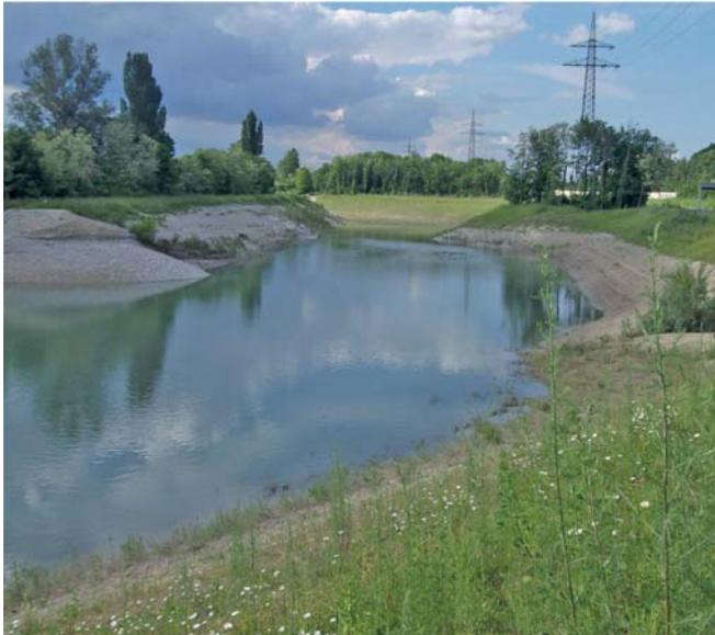
**Abb. 2:** Blick in den als Teilfläche 3.1 bezeichneten nördlichen Abschnitt der Untersuchungsfläche. Links im Bild ist der temporär belassene Schutzwall zum Rhein erkennbar. Der Anschluss an den Rhein erfolgt durch je einen Durchlass im Süden und im Norden, so dass die Fläche vom Wasser durchströmt werden kann (Foto Jan Reindl, Juni 2013, Blick nach Norden).
