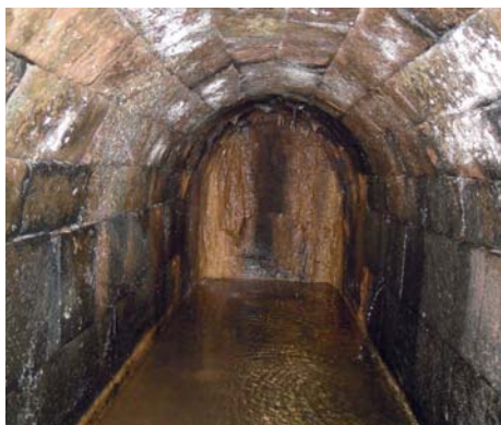
Abb. 10: Tunnelförmiger Durchlass mit Schütz (2016). Fig. 10: Tunnel-shaped passage with sluice (2016).
