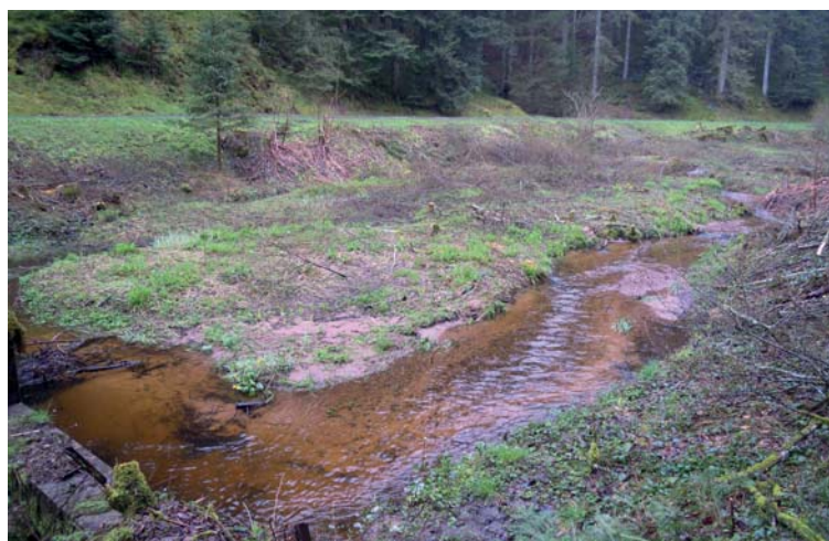
Abb. 15: Verlandete Fläche hinter der Stau- mauer im Heubach. Fig. 15: Silty areas behind the dam wall at Heubach.
