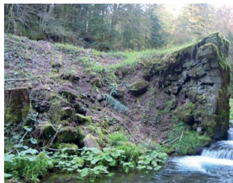
Abb. 8: Absturzgefährdete Mauer Talseite. Fig. 8: Walls in danger of falling, valley-side.
