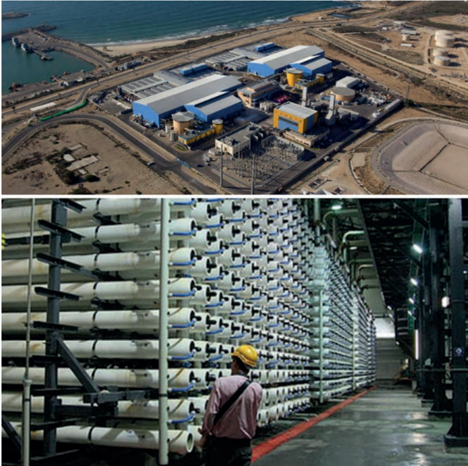
Abb. 7: In der Anlage in Ashkelon im Südwesten Israels ( www.ide-tech.com ) wird Meerwasser mit dem Verfahren der Umkehrosmose entsalzt. Fig. 7: The Ashkelon Plant in southern Israel ( www.idetech.com ) desalinates sea-water by reverse osmosis.
