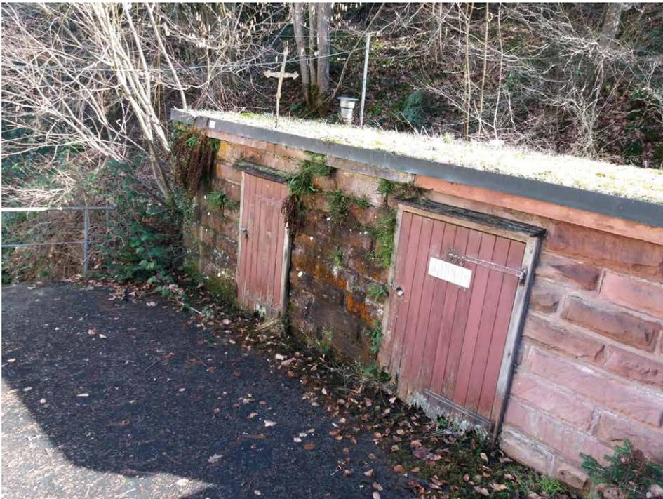
**Abb. 33:** Brunnenstube der Quelle Bad Kirnhalden; links Geländer über dem Bach; Heiliges Kreuz und Entlüftungsrohr links auf dem Dach der Brunnenstube; Foto: B.G., 20.12.2022. **Fig. 33:** Water spring chamber of Bad Kirnhalden; to the left the railing over the creek.
