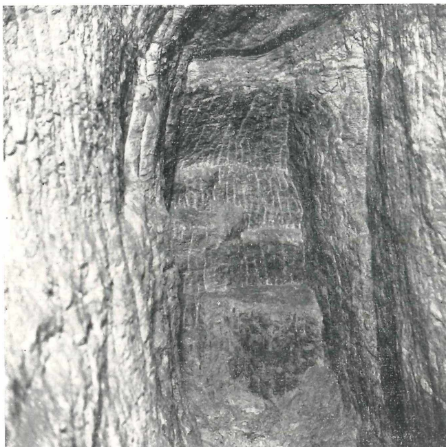
Abb. 3: Spuren mittelalterlicher Schlägel- und Eisen-Arbeit am Feldort des alten Antonstollens bei Wieden/Schwarzwald
