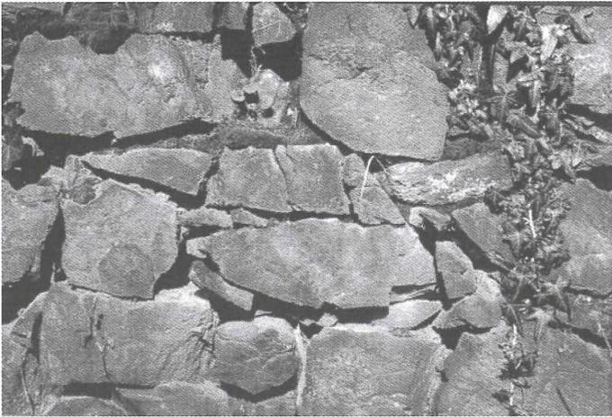
**Abb. 12:** Mauerwerk am Schlossberg-Südhang (TK 8013 Freiburg Südost). Dunkle Fulguritanflüge an den Kanten und angrenzenden Flächenteilen der Mauersteine, davon kaum unterscheidbar auch dunkle Überzüge aus Flechten.
