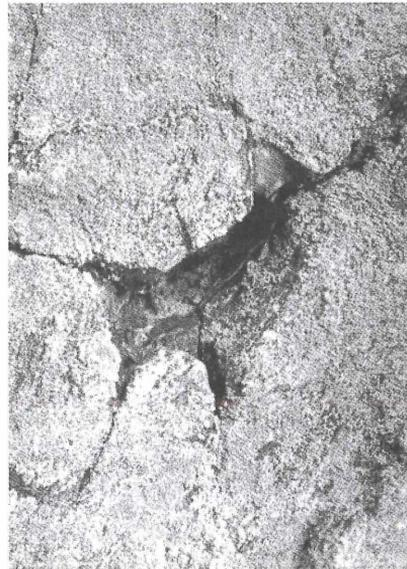
**Abb. 8:** Aussprengung mit Fulguritbelägen in dem Felsen der Abb. 7. Höhe des Bildausschnitts 30 cm.
