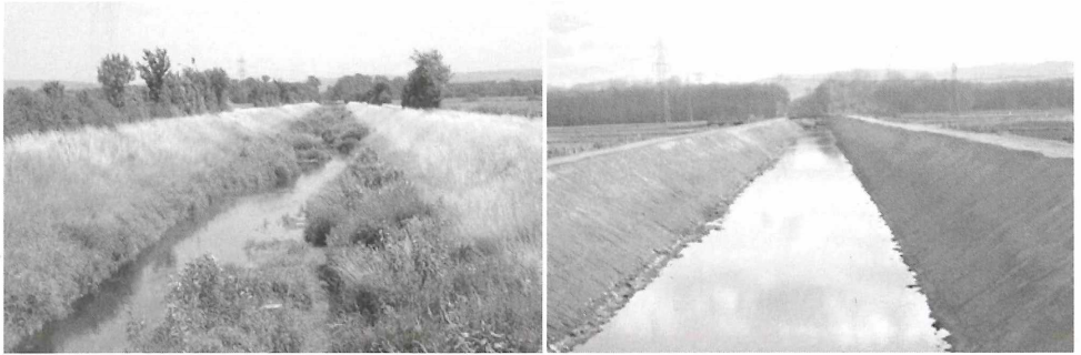
Abb. 5: Der gleiche Gewässerabschnitt am Schutter-Entlastungskanal vor und nach der Räumung. In diesem Abschnitt sind nach der Räumung keine Strukturen mehr vorhanden, die Fischen oder anderen Organismen als Unterstand oder Habitat dienen könnten.
