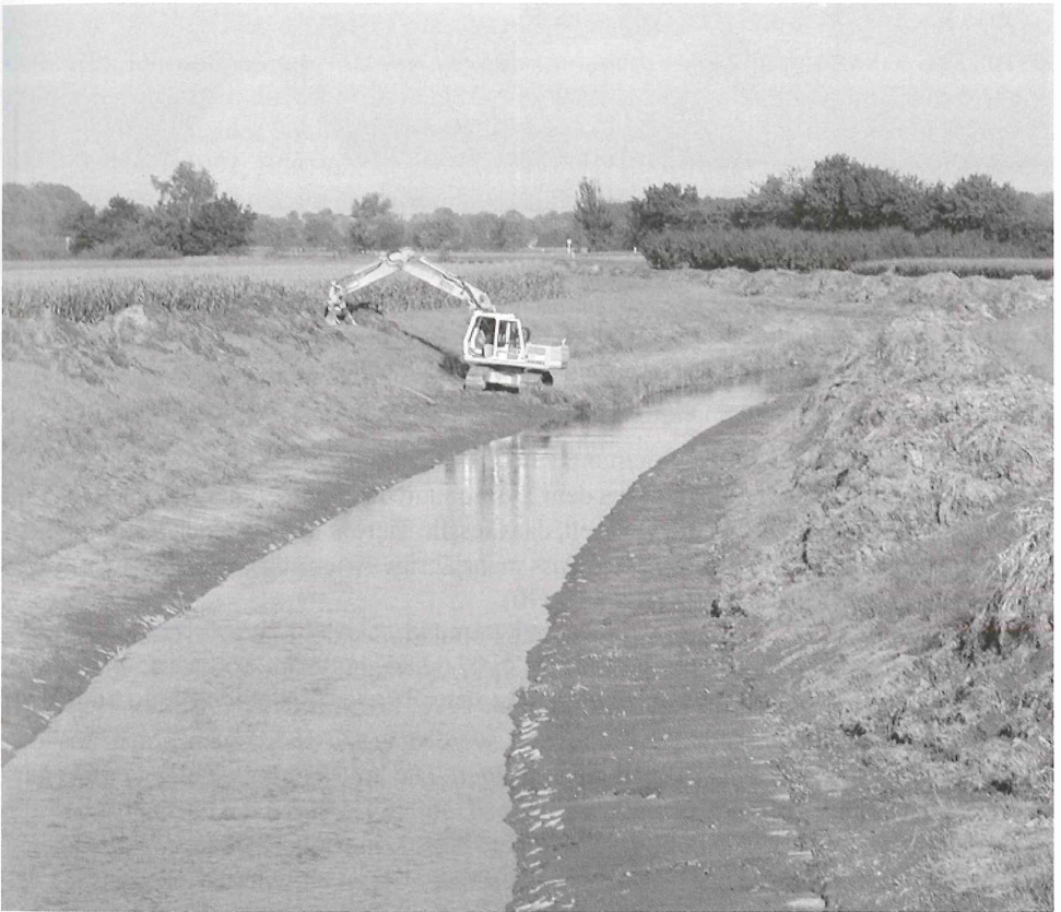
Abb. 4: Räumung an der Acher. Das Material wird aus dem Gewässer entfernt and am Ufer abgelagert.
