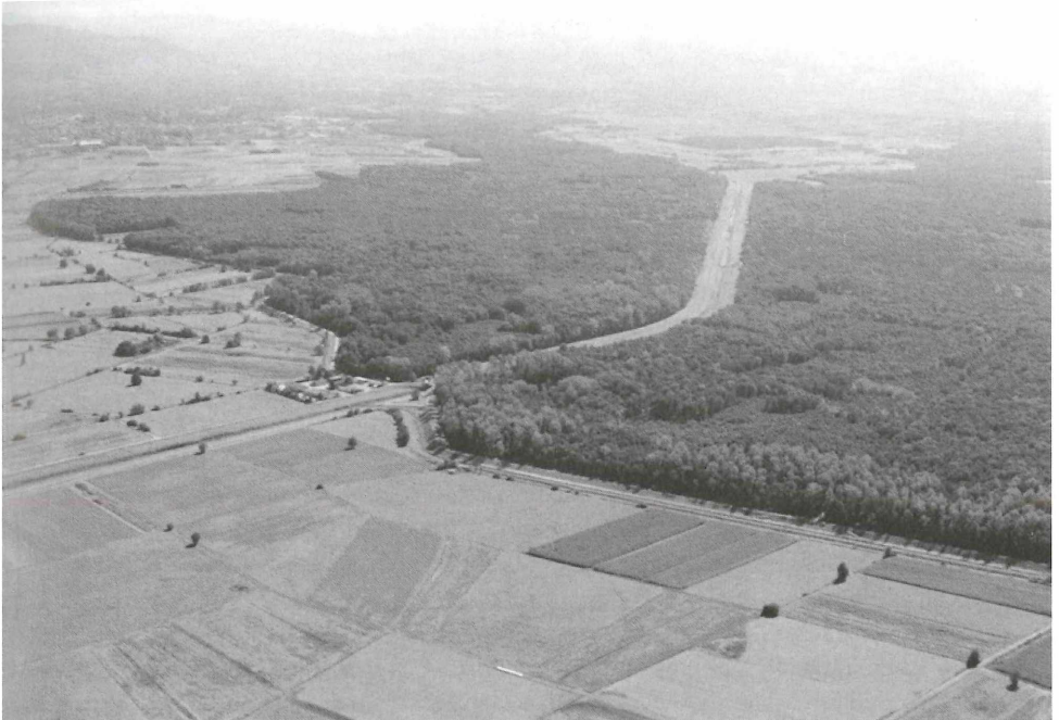
Abb. 2: Geradliniger Verlauf des Rench-Flutkanals. Drei bewaldete Hochwasserrückhaltebecken flankieren den Rench-Flutkanal.
