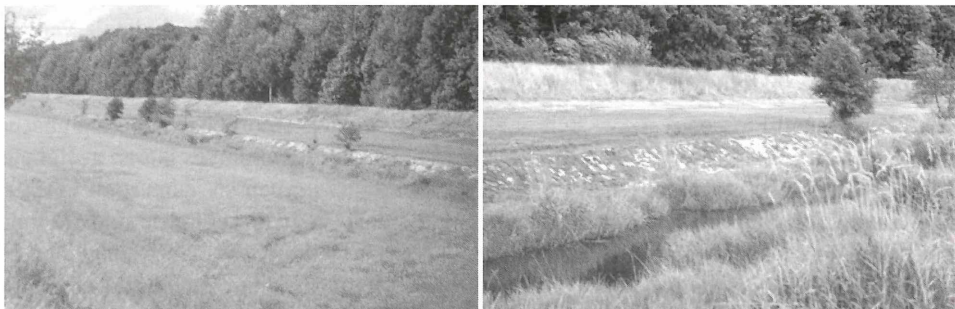
Abb. 6: Rechtsseitiger Vorlandabtrag und halbseitige Mittelwasserbetträumung am Rench-Flutkanal.
