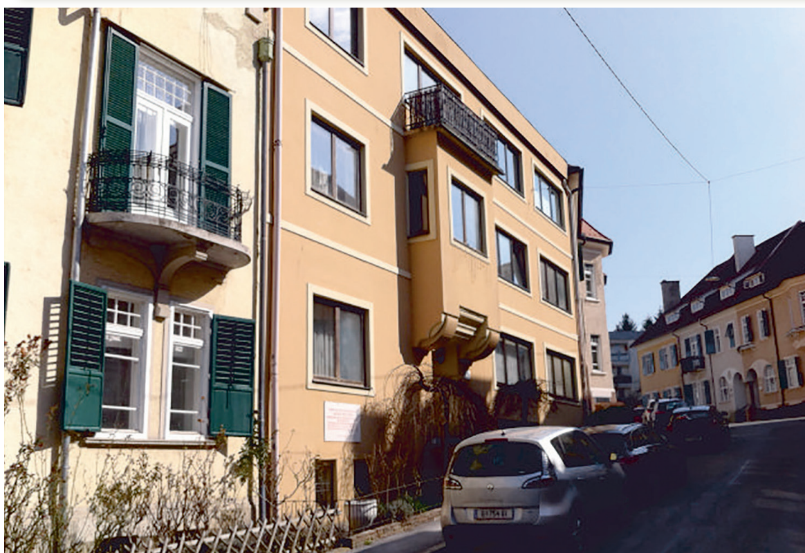
Abbildung 4, oben: Das Wohnhaus Wegeners in der Blumengasse 9 (seit 1931 Wegenergasse) in Graz (Waltendorf). Den seitlichen Zubau mit Balkon ließ Wegener 1926 machen (Foto: apx 1950). Unten: Am einstigen Wohnhaus Alfred Wegeners, das 1972 umgebaut wurde, befindet sich seit 1980 eine Gedenktafel, die an den großen Forscher erinnert. Top: The house of Wegener in the Blumengasse 9 (since 1931: Wegenergasse) in Graz (Waltendorf). The annex with the balcony was made by Wegener in 1926 (Foto: apx 1950). Bottom: At the former house of Alfred Wegener, which was totally rebuilt in 1972, a plaque commemorates since 1980 to the great scientist.
