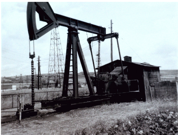
van Sickle 1980er: Zentralantrieb mehrerer Tiefpumpen über Seilzüge [aus: Sammlung Goth\St.Ulrich-Hauskirchen-van Sickle]
