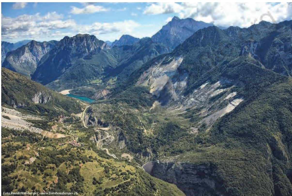
Abb. 5. Massenbewegung Vajont aufgenommen bei einem Flug über dem Piavetal; Blickrichtung Osten (Vajonttal aufwärts); im Vordergrund die Staumauer, Gleitfläche rechts, Restspeichersee im Hintergrund; Piavetal parallel zur Bildebene. (aus: STÜWE & HOMBERGER, 2011)
