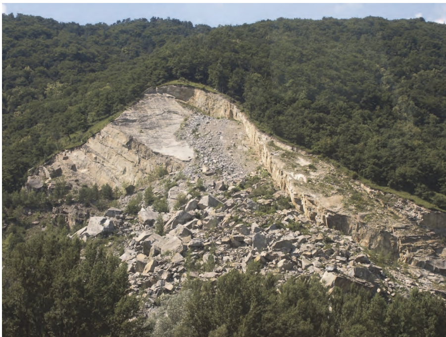
Abb. 2. Abgleiten von Felsmassen auf einer Ebene in großen Dimensionen im ehemaligen Tagbau Spitz an der Donau am 11.10.2002 (Blickrichtung Westen)
