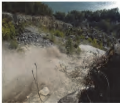
Abb. 5: Auslösung von Steinschlägen im obersten Steinbruchbereich (unterhalb von St3) durch den Trupp der örtlichen Straßenmeisterei.
