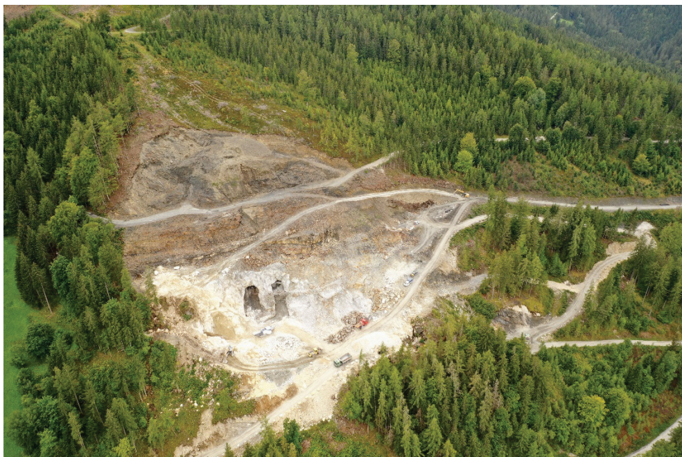
Abb. 7. Tagebau Angerer der STYROMAG GmbH. Die ehemaligen Abbaukammern des Untertagebaues kommen durch die Erweiterung des Tagebaues an das Tageslicht (Foto: P. Kroissenbrunner, 2022).
