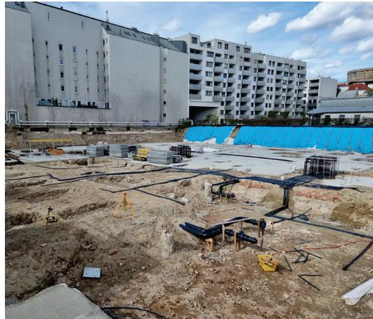
Abbildung 7: Als Bodenplattendurchführung ausgeführten Verteiler (Abb. links) Anbindeleitungen am Beispiel Baufeld D - LeopoldQuartier (Abb. rechts).
