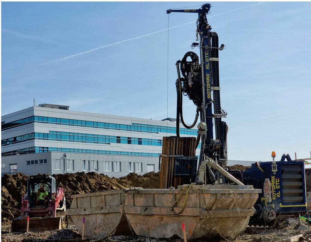
Abbildung 2: Geräteeinheit für Rotary-Druckspülverfahren, inkl. zusätzlicher Schlammulde, exkl. Verpresseinheit.
