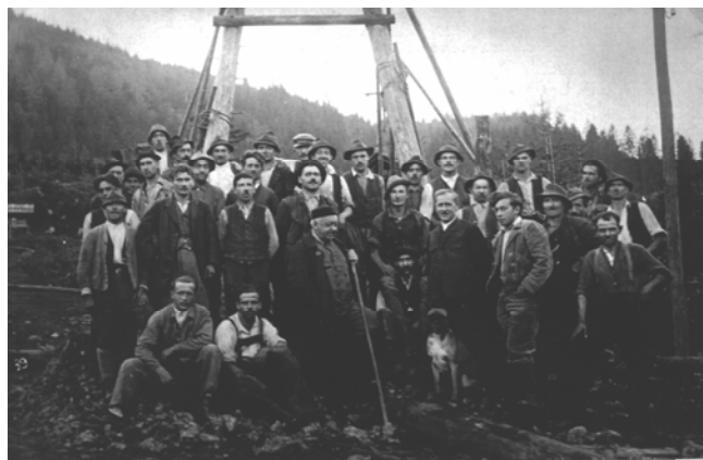
Abb. 2: Unterlaussa. Kohlenbergbau Sandl der Firma Josef Reithoffer's Söhne, Gummi- und Kabelwerke in Steyr. Reparatur der Seilbahn zwischen Bergbau und Unterlaussa/Dörfl. Vorne in Bildmitte: Josef Koestler (mit Bergstock)
