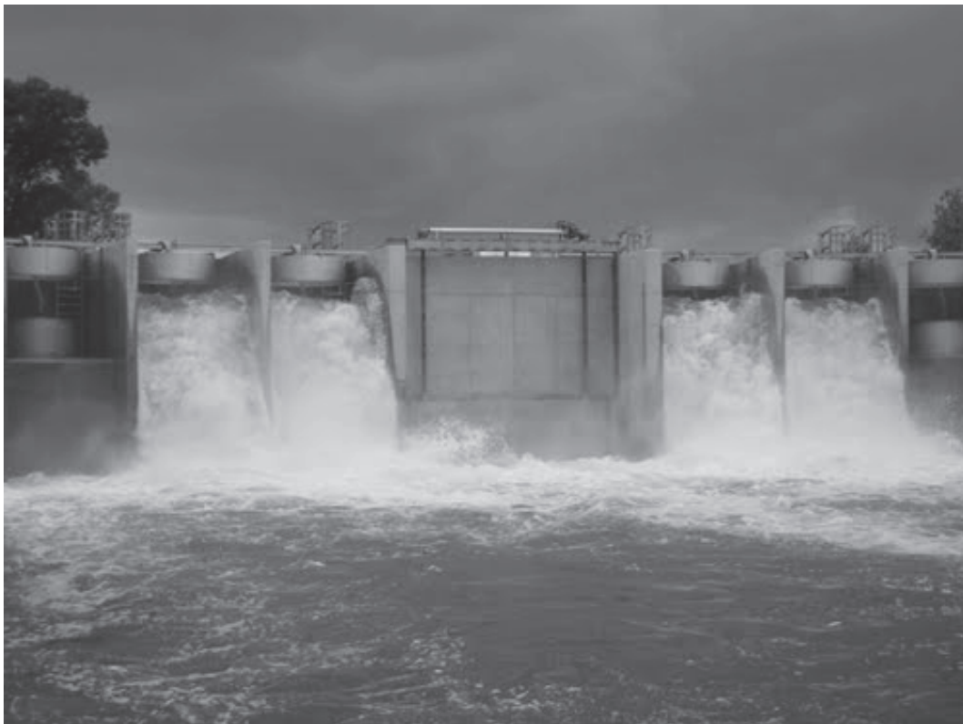
Abb. 10: Pumpwerk Fischamend, Einsatz beim Hochwasser 2011
