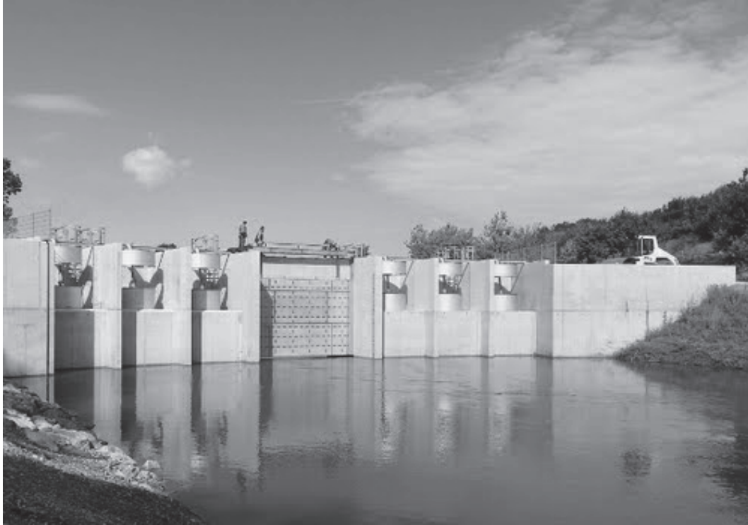
Abb. 9: Pumpwerk Fischamend, Bauphase
