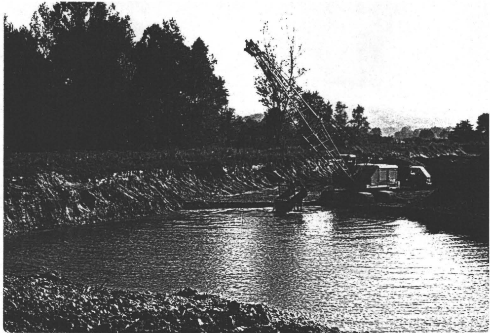
Abb. 14: Kiesabbau 14=203 mit dem Seilzugbagger und zugehörige Sortieranlage
