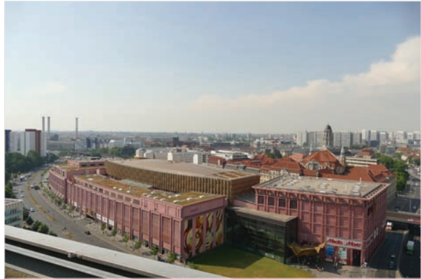
Abb. 3: Alexa mit nördlichem (rechts im Bild) und südlichem Kiesdach (links hinten), 23.05.2016. – Alexa with northern (to the right) and southern (rear left) gravel roof. Foto: K. Steiof
