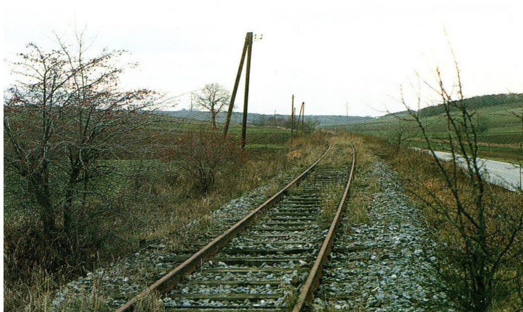
Abb. 5: Zustand der Bahnstrecke westlich von Kleinhadernsdorf im Jahr 1992. Gleise, Bahnschwellen sowie die Trassen begleitende Leitung sind noch vorhanden, ebenso ist beginnender Gehölzaufwuchs zu erkennen. / State of the railway line west of Kleinhadernsdorf in 1992. Tracks, sleepers and the cable along the railway line are still present; beginning growth of wooded vegetation is visible. Quelle: Berg & Zelz (1994).
