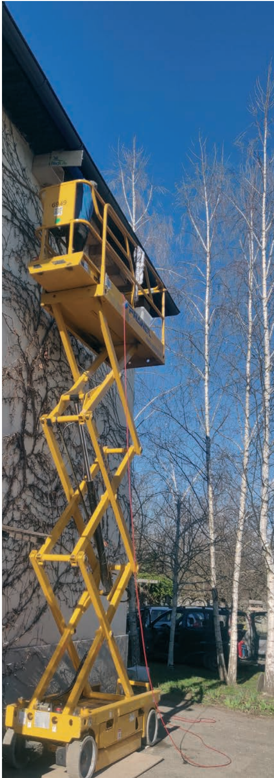
Abb. 2: Die Hebebühne im Einsatz. Foto: H. Plasch
