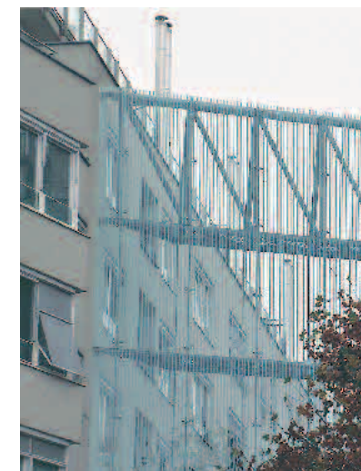
Breite Streifenmuster wie bei diesem Windschutz machen Glas für Vögel gut sichtbar und schützen so vor Vogelschlag.
