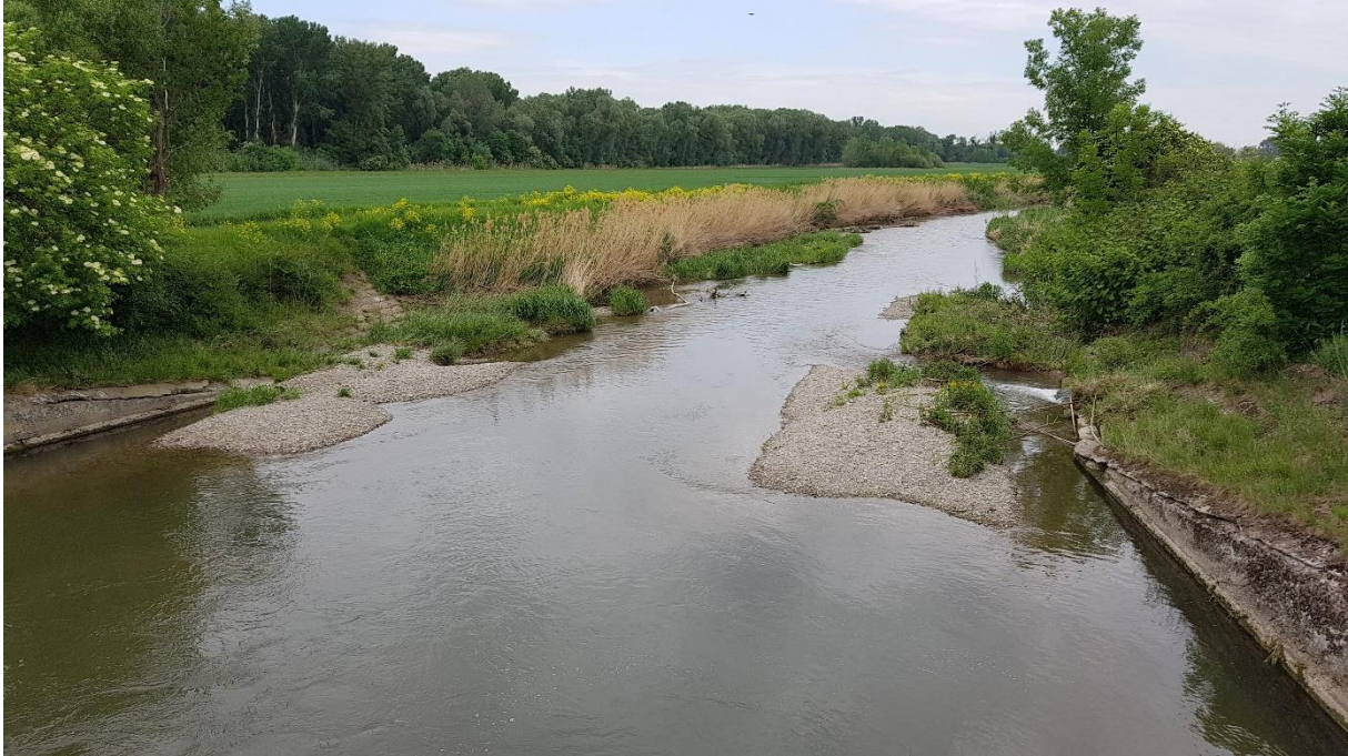
Foto 13: Die befestigten Schwechat-Ufer im Abschnitt sc_197 verhindern ein Mäandrieren und geben dem Fluss einen kanalartigen Charakter. Durch Entfernung des Blockwurfs und der Uferbefestigung bzw. einer Renaturierung des Abschnitts könnte die Habitatsituation für den Eisvogel deutlich verbessert werden.
