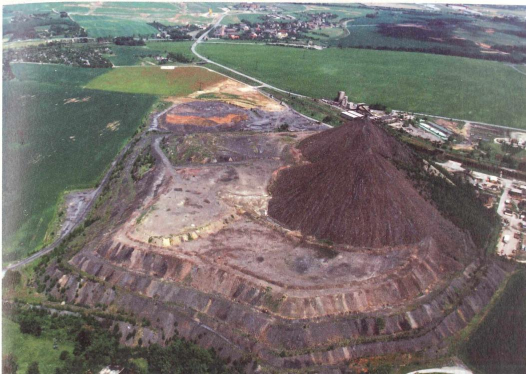
**Abb. 2:** Spitzkegelhalden Paitzdorf mit vorgelagerter LKW-Halde zur Zeit des aktiven Bergbaus.
