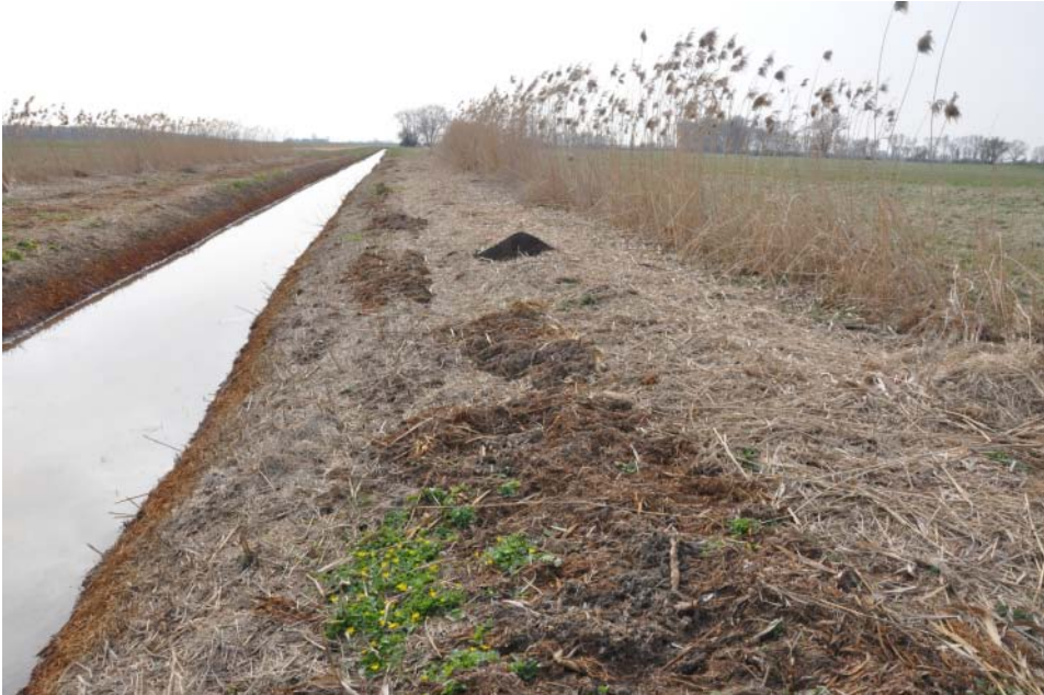
Abb. 4: Gräben direkt nach Räumung. Bei der Räumung werden sowohl Pflanzen als auch Substrat aus dem Graben entfernt. Riedwiese, 27. März 2011, Foto Egbert Korte – View of a ditch (Riedwiese) immediately after being cleared, 27 March 2011. Vegetation and mud were removed during the procedure.
