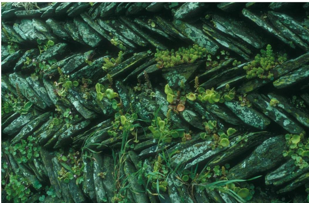
Abb.5: Struktur einer Trockenmauer bei Tintagel.
