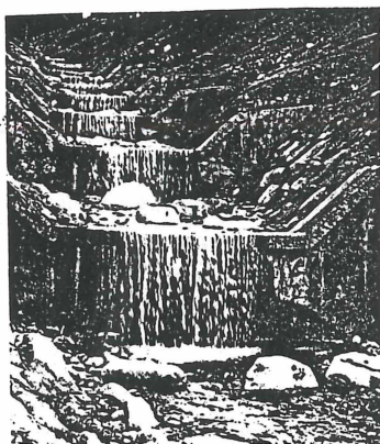
Der Zirkenbach bei Mieders im Stubaital als Beispiel für eine Wildbachverbauung
