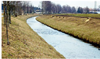
Abb. 1. Vor der Restrukturierung war dieser Abschnitt der Glan monoton und naturfern. Foto: A. Lumetzberger ©
