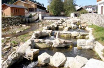
Abb. 2. Überblick über die Fischwanderhilfe. Die Übergänge zwischen den Becken sind als sohl offene Schlitzte ausgebildet
