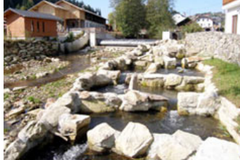
Abb. 2. Überblick über die Fischwanderhilfe. Die Übergänge zwischen den Becken sind als sohl offene Schlitzte ausgebildet Foto: Umweltgutachten Petz OG ©
