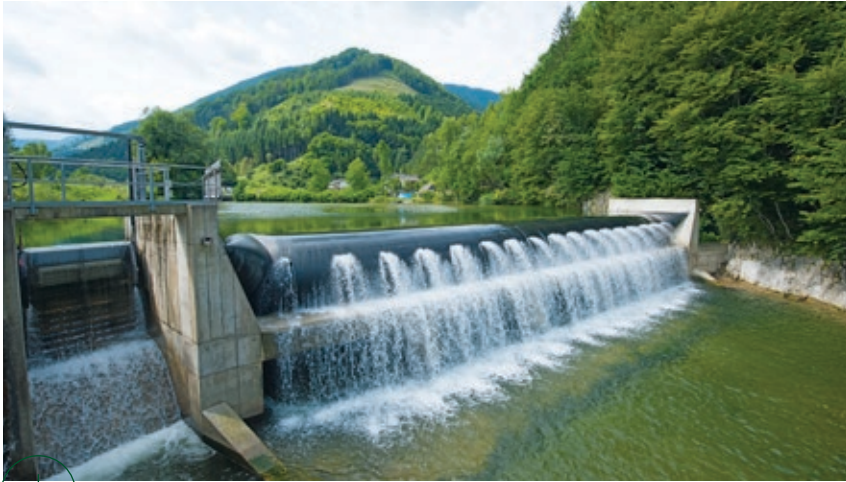
Wassererfassung beim ÖBf-Kleinwasserkraftwerk Schallau bei Reichraming
