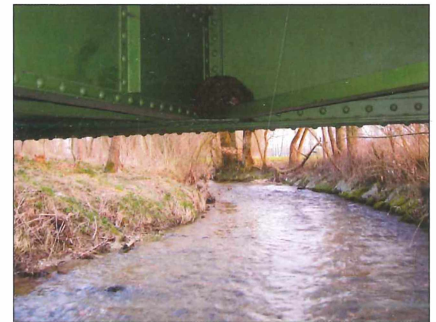
Auf den Eisentraversen auf einer Brücke
