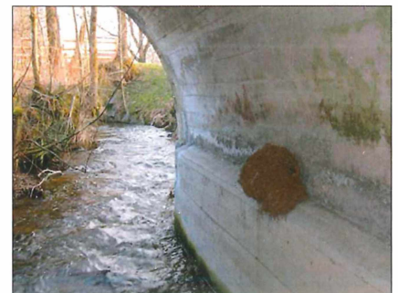
Auf einem Vorsprung unter einer Betonbrücke
