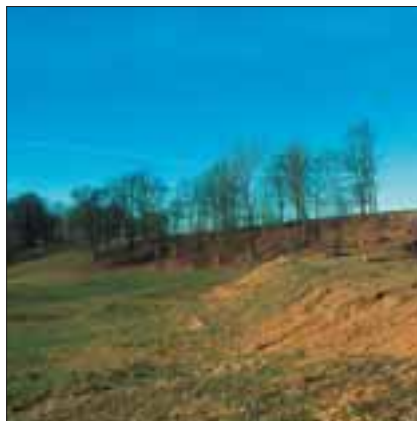
Abb. 47: Das reizvolle Tal des Gurtenbachs bei Gurtenhof (St. Georgen bei Obernberg) wird derzeit brutal mit Baggern verunstaltet.
