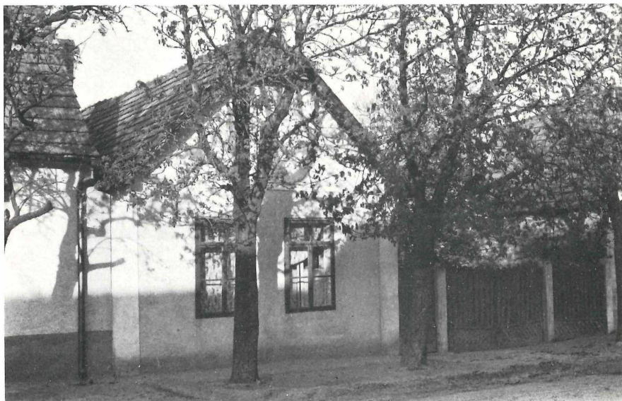
Abb. 2: Haus, das von diesen Geldsendungen noch vor der Rückkehr des Absenders erbaut wurde. Fot. Frühjahr 1975.
