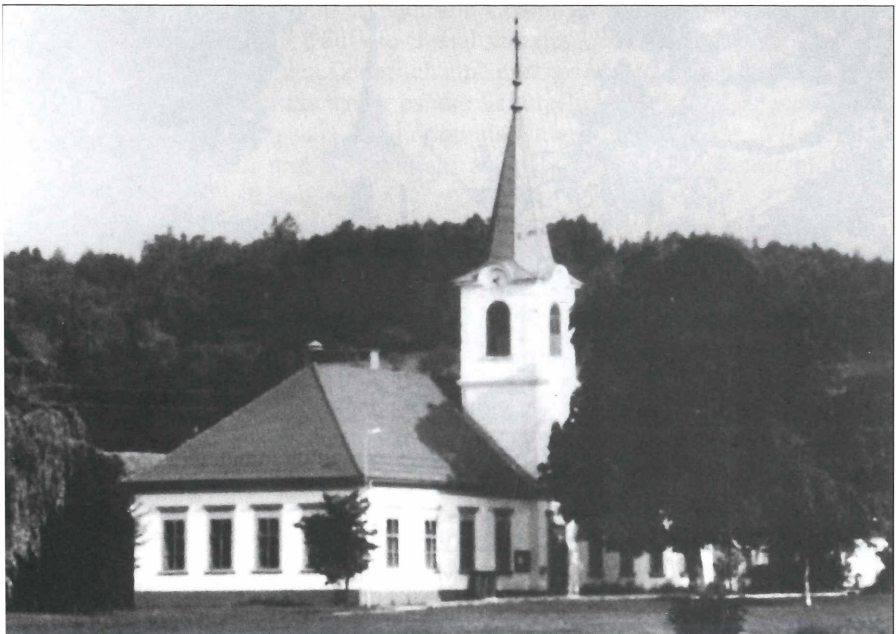
Evang. Bethaus in Willersdorf (ehemalige Turnschule), erbaut 1880
