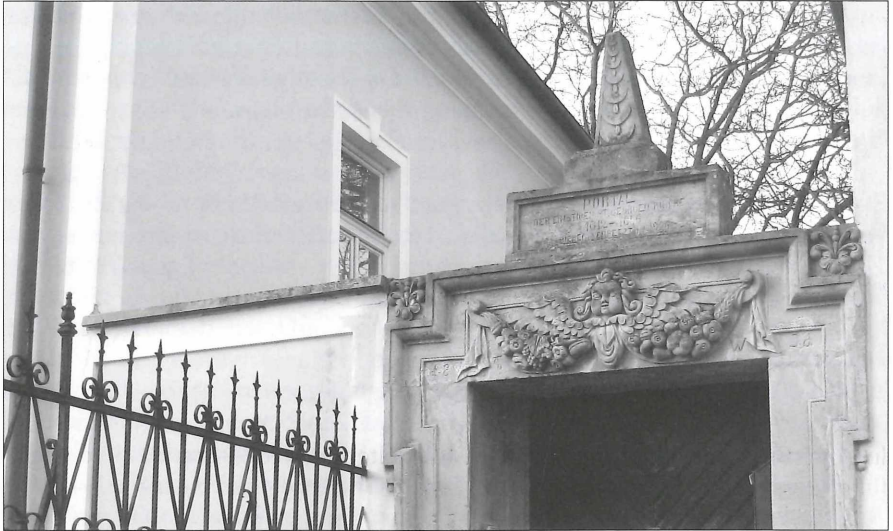
Das ehemalige Portal der Georgskirche
