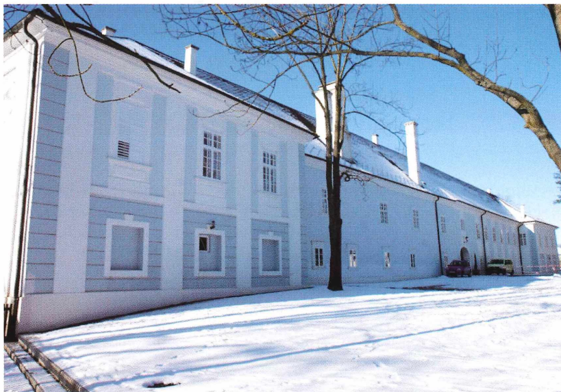
Bild 6: Schloss Lackenbach, NO-Flügel derzeitiger Zustand
