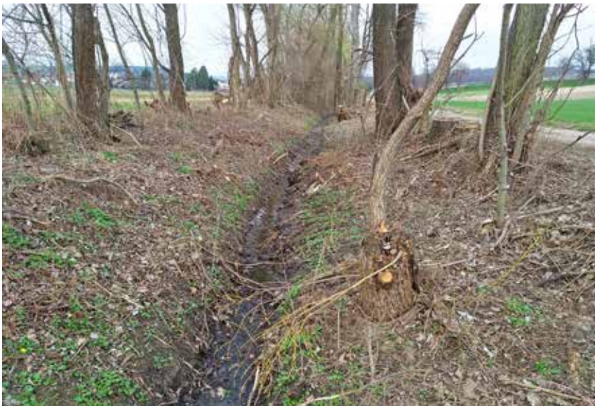
Positives Beispiel für Bachgehölzpflege in Ritzing: Abfluss ist gewährleistet, trotzdem bleiben große Bäume und Sträucher stehen.
