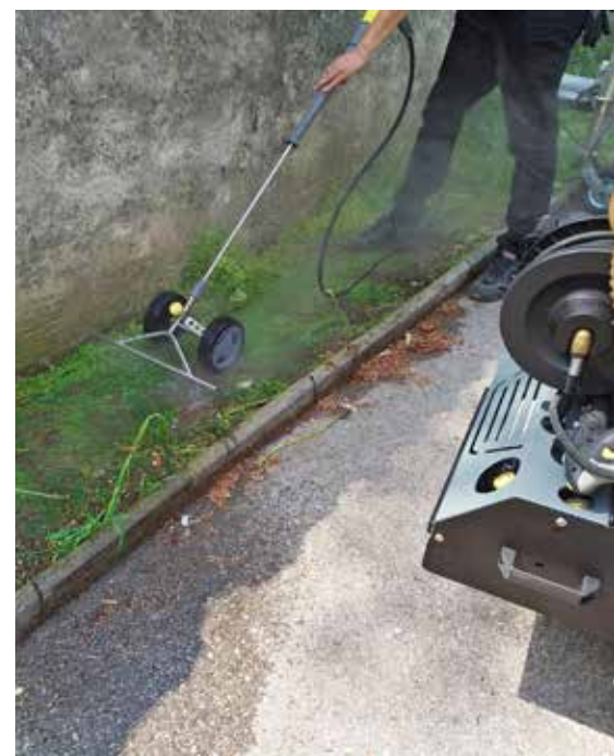
Alternative Unkrautbekämpfung mittels Heißwasser (oben) und mechanisch (rechts)
