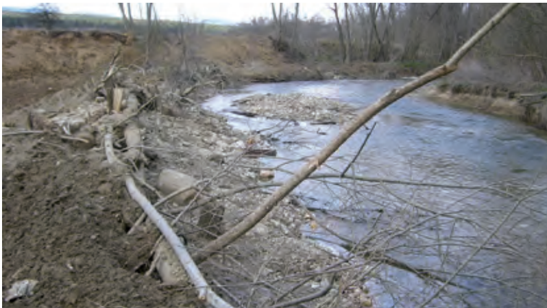
Sanierung mit ingenieurbiologische Maßnahmen.
