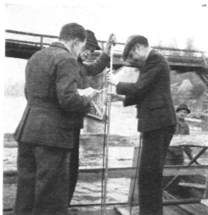
Abb. 2: Abflußmessung unterhalb der alten Draubridge bei Tainach-Stein. Meßbühne zwischen zwei Booten, die über Rollen an einem von Ufer zu Ufer gespannten Drahtseil befestigt sind. Sichtbar ist das Gestänge zur Führung des Flügels.
